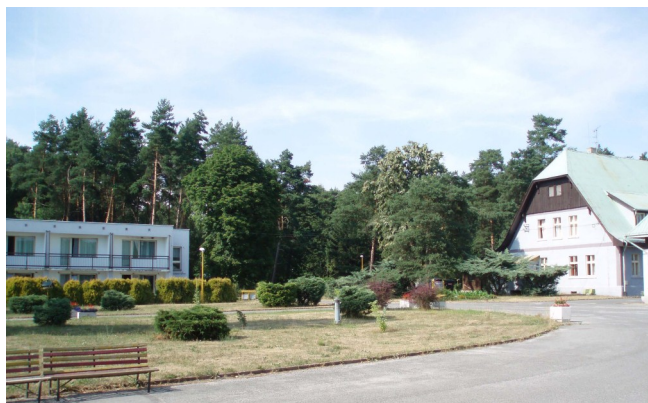
Pohled na novou a starou budovu
